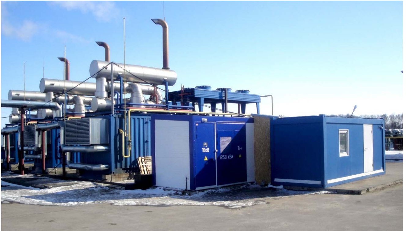
Рисунок 6.1 – Экспериментальная установка для испытаний совместной работы СНЭ-10-1200-400 и ГПУ
