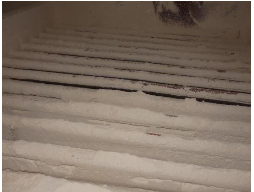
Рисунок 3.22 – Занос стального экономайзера с коридорным расположением труб золой подсолнечной лузги
