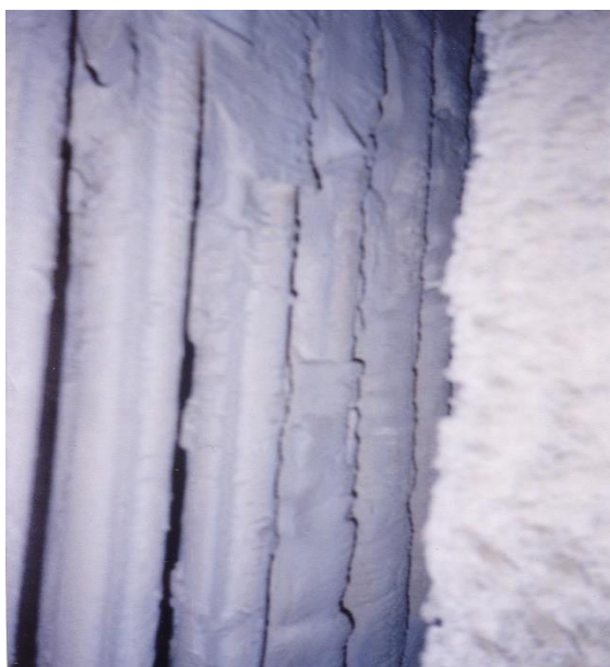
Рисунок 1.29 – Быстрое зарастание котельного пучка отложениями золы
