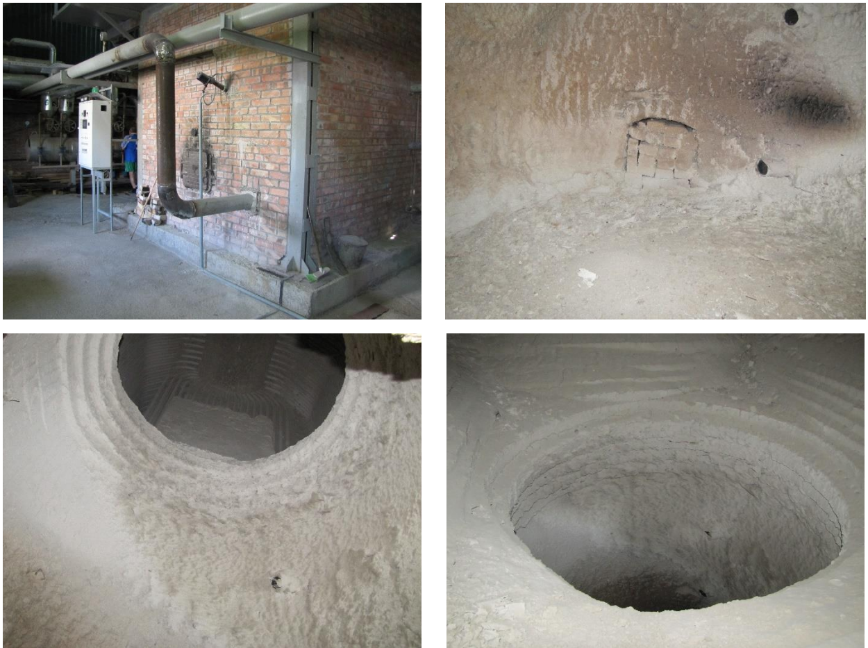
Рисунок 2.20 – Неэкранированная вихревая топка для сжигания лузги.
