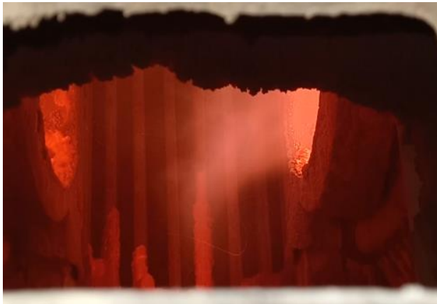
Рисунок 2.38 – Вид отложений и пламени из ГОО: слева – котел Е-16 с вихревой топкой и двухкамерным сжиганием; справа – Е-14 с вихревой топкой «Торнадо»
