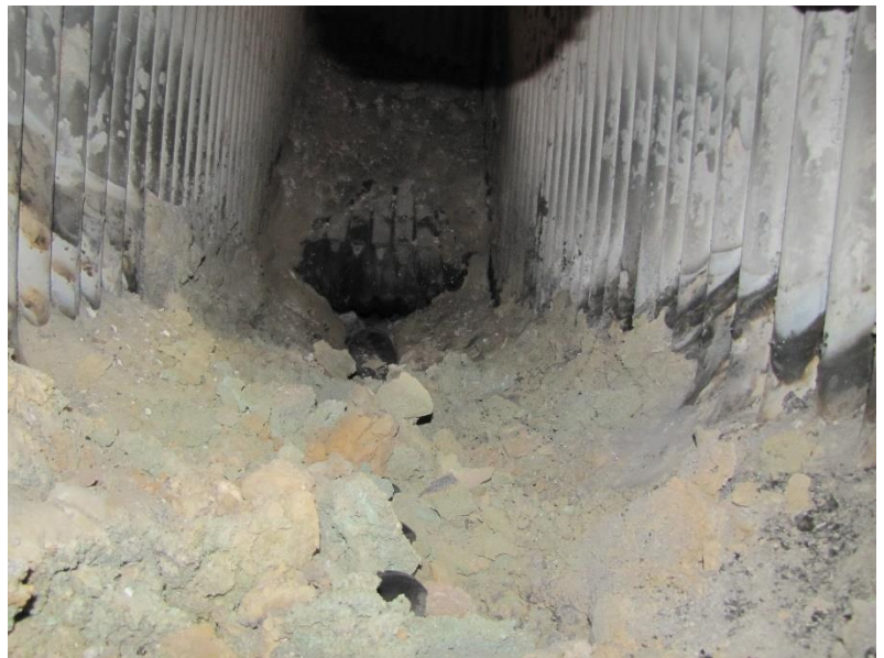
Рисунок 3.14 – Шнек золоудаления и спекшиеся зольные отложения в нижней части вихревой топki
