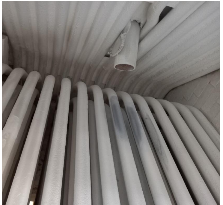
Рисунок 3.17 – Работа газо-импульсной очистки. Ширина очищаемой зоны много меньше ширины конвективного пучка труб
