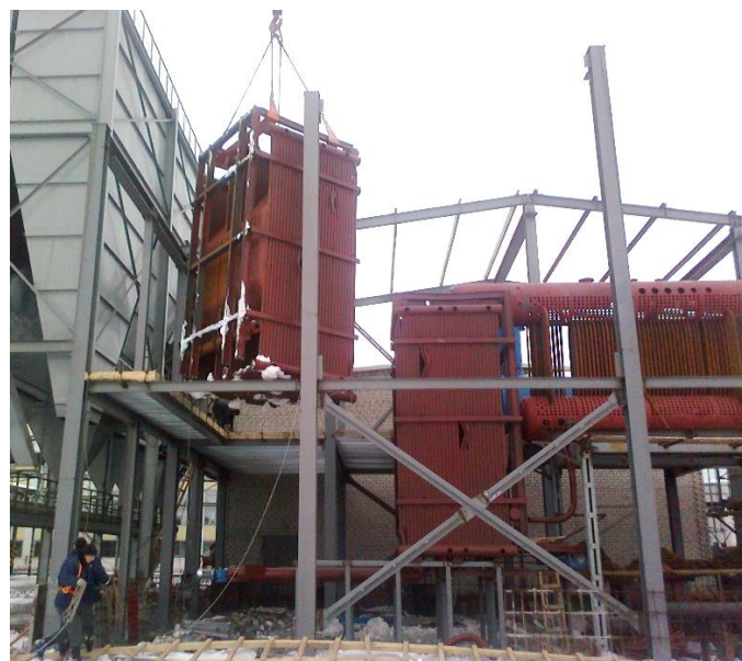
Рисунок 4.1 – Монтаж блоков котла с вихревой топкой КЕ-25-24 РТО
