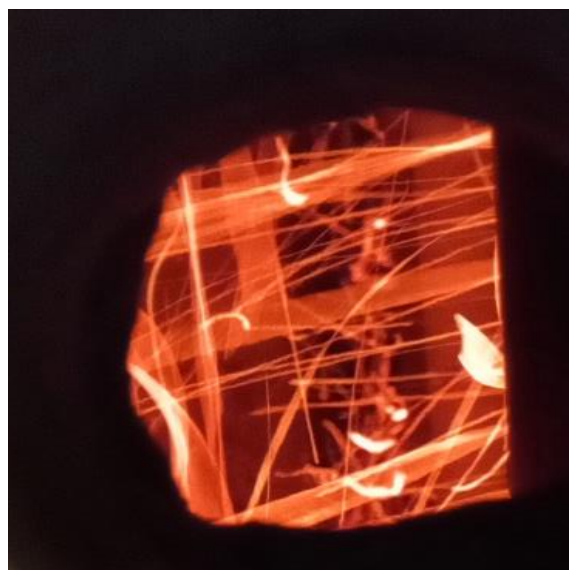
Рисунок 1.32 – Искры уноса в газоходе после экономайзера котла Е-15-1,4 с открытой камерной топкой при сжигании подсолнечной лузги на полной нагрузке
