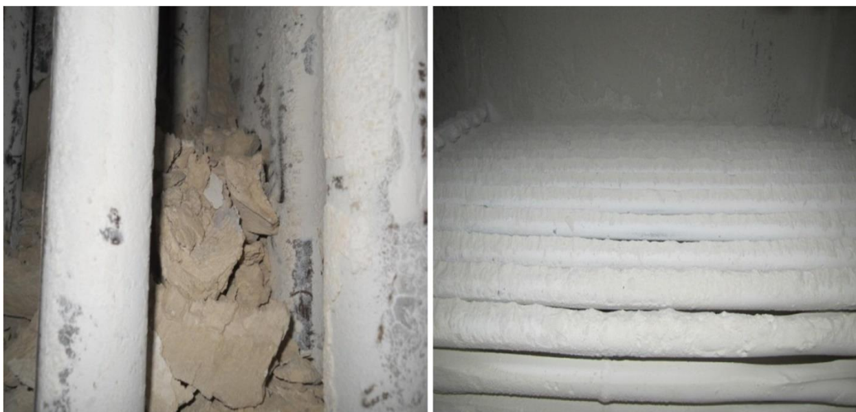
Рисунок 3.6 – Вид отложений: слева – на входе в конвективные пучки (прочные крупные отложения, до 200мм); справа – в экономайзере (рыхлые)
