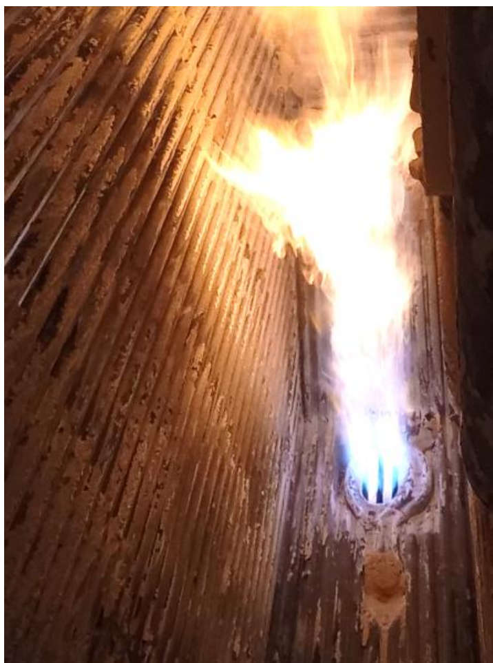
Рисунок 4.6 – Горение природного газа. Виден факел фронтальной горелки и двухцветный разделительный экран
