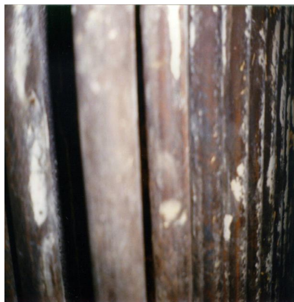
Рисунок 1.30 – Очищенный от отложений золы котельный пучок [44]
